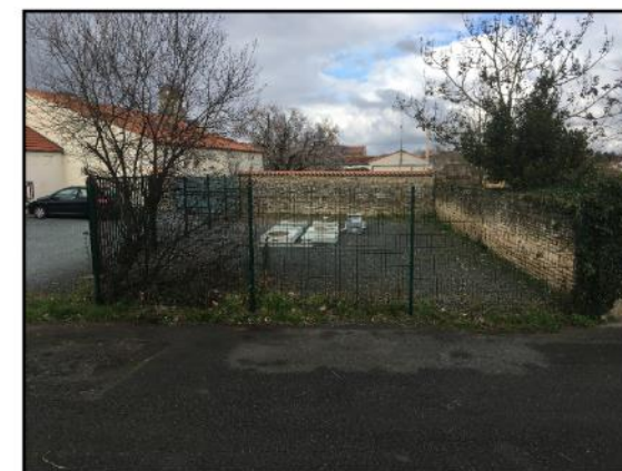
Photographie de la STEP EHPAD
